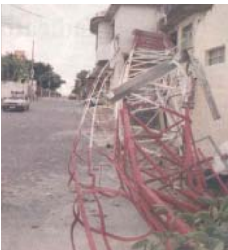
Figura 3: Torre de telefonia celular caída em 25/11/2002, no bairro Filadélfia, em Betim, Minas Gerais. Jornal Estado de MG, n.º 22.249, 27/11/2002, Caderno Gerais.
